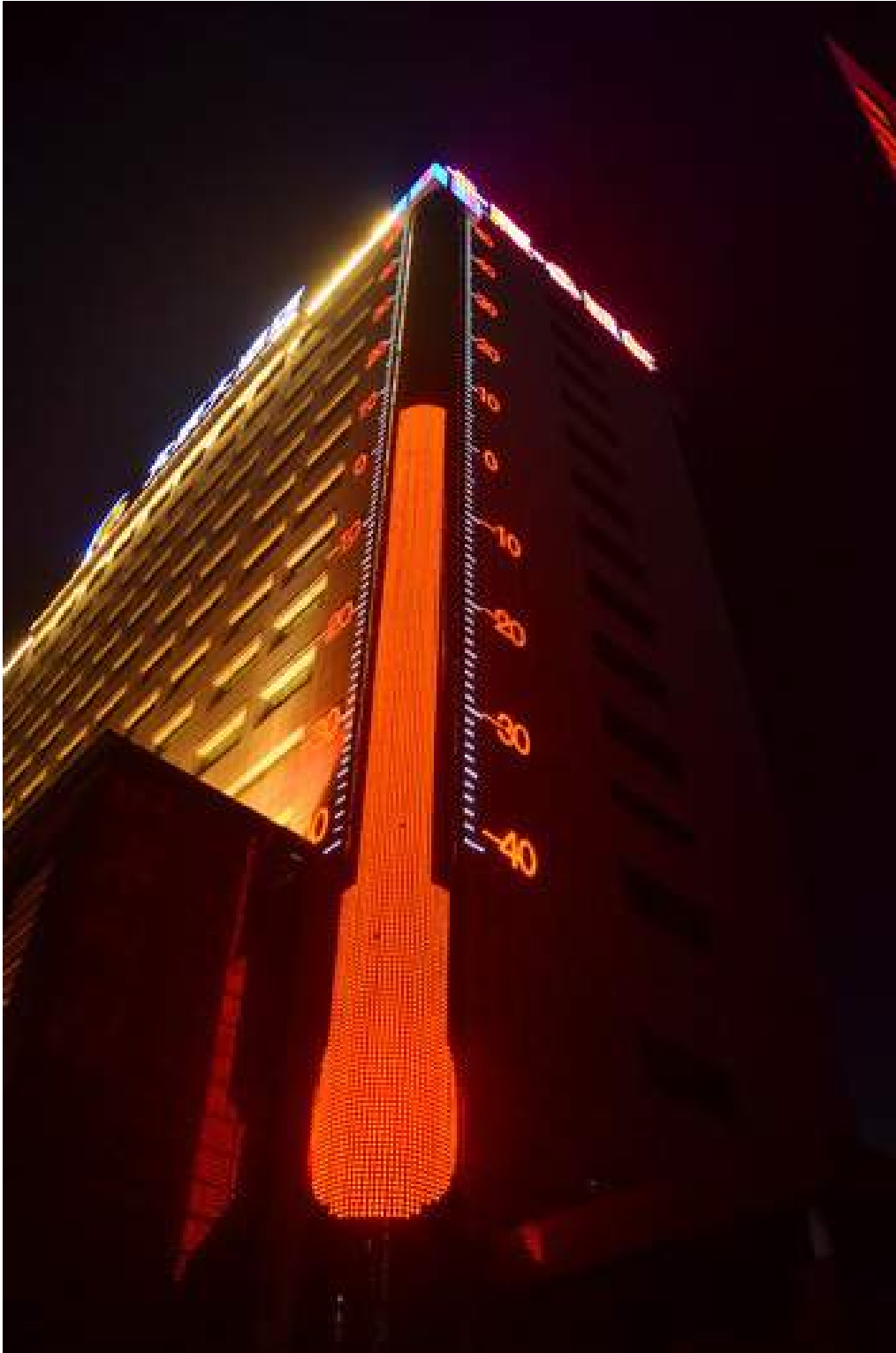
Het thermometer gebouw in Shenyang trekt de aandacht van voorbijgangers, bron: People's Daily Online/Chen Fuyi , 2015
